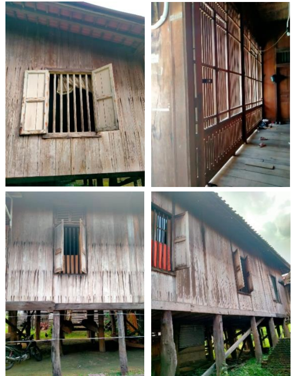
Gambar 7. Ruang Masuk dan Bentuk Jendela
