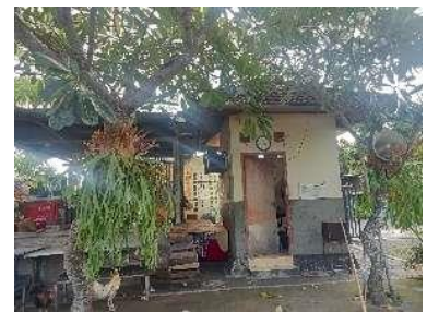
Gambar 5. Kondisi Bangunan Pengelola Taman Mayura (Sumber : Dokumentasi pribadi)
