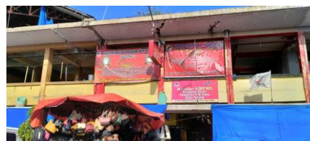
Foto bagian bangunan yang tertutup Sumber : Dokumentasi Penulis
