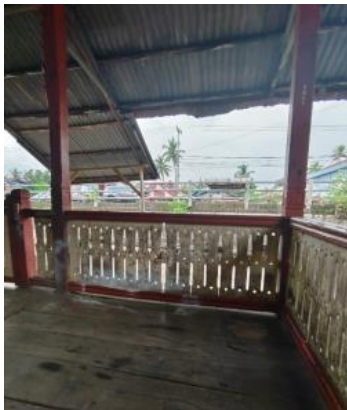
Gambar 5. Lantai Bangunan menggunakan material Kayu/Papan Sumber: Peneliti, 2024
