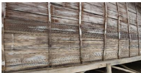
Gambar 6. Dinding Bangunan menggunakan Material Bambu yang dianyam dan dipipihkan Sumber: Peneliti, 2024
