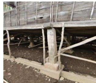
Gambar 8. Pondasi Tiang Kayu Sumber: Peneliti, 2024
